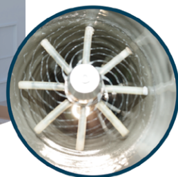
Tercer paso: REHABILITACIÓN
