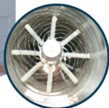
Tercer paso: REHABILITACIÓN
