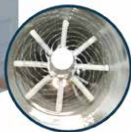
Tercer paso: REHABILITACIÓN
